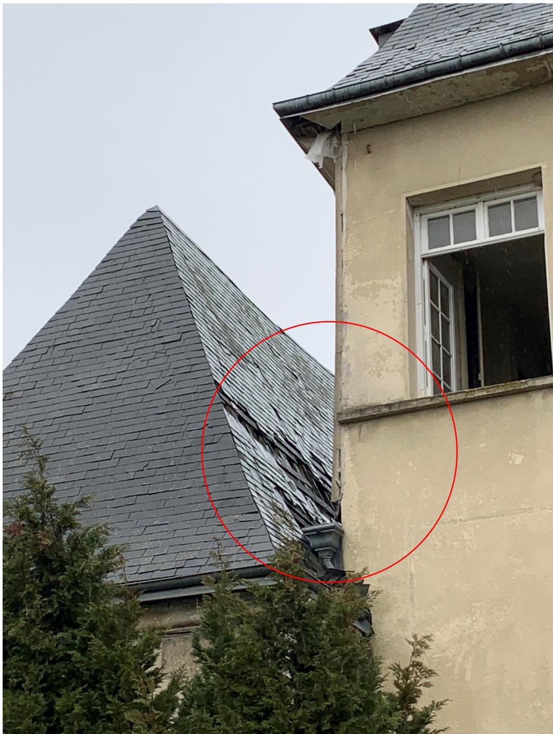
Figure 13 Photographie avec présence d'un trou béant consécutif à une chute de gouttière prise en février 2021
